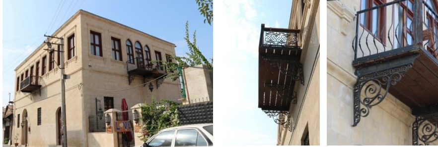
Şekil 5. Eski Askerlik Şubesi yapı görselleri
